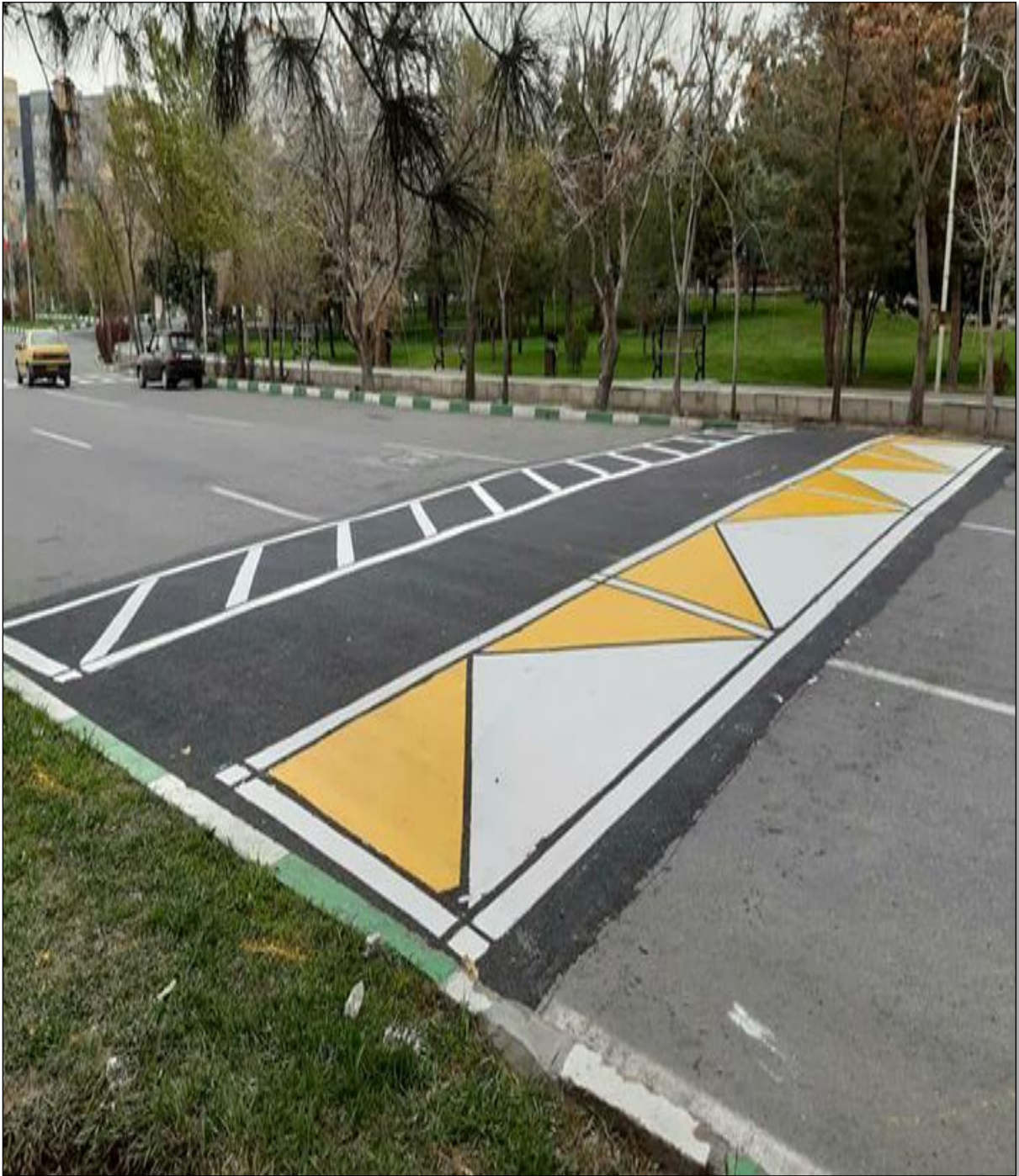
تصویر (12) : نمونه اجرا شده خط کشی سرعتگاه 7 متری
