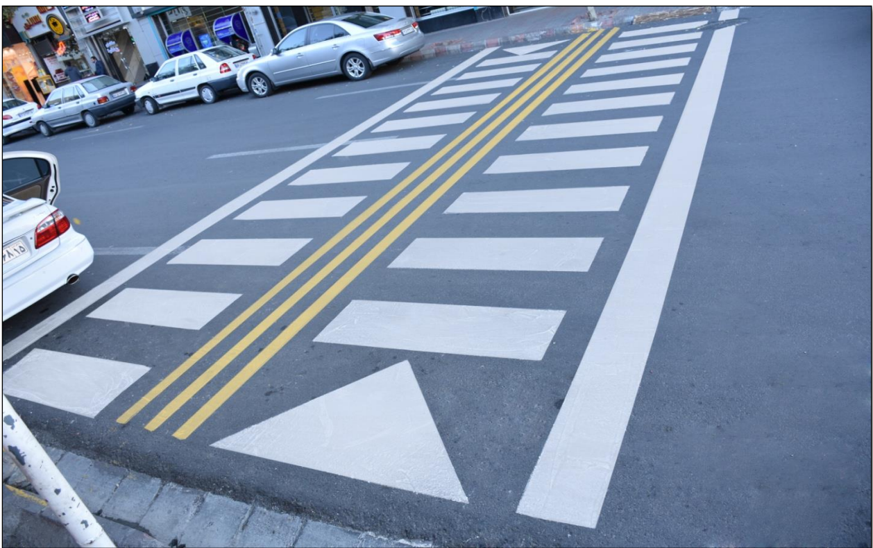
تصویر (6): نمونه اجرا شده خط کشی عابر پیاده در سطح شهر
